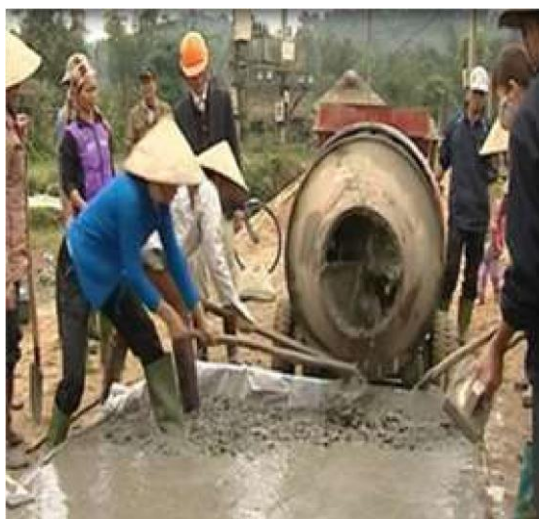
Hình 3. Nhân công đổ sàn bê tông bằng nguồn nước giếng khoan
